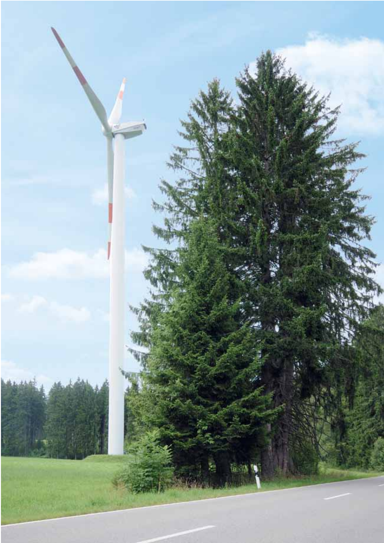
Zahlreiche Flächen der ESPS eignen sich sehr gut als Standorte für Windenergieanlagen. Hier zum Beispiel auf dem „Windkopf“ bei Tennenbronn im Schwarzwald.
