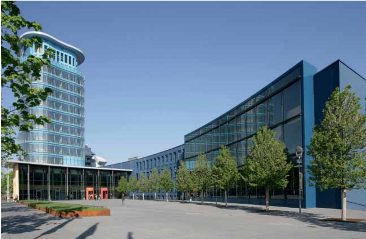
Gebäude der 2004 eingeweihten SRH Hochschule Heidelberg und die 2011 in Betrieb genommene Mensa „cube“
