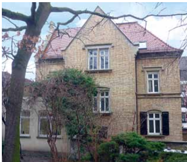
Auf Wandtemperierung umgestellt: Das Pfarrhaus der Matthäuskirche in Mannheim-Neckarau.
