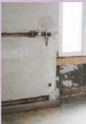
Beim Einbau der Wandtemperierung im Pfarrhaus Mannheim-Neckarau wurden lange Rohre in die Wände eingelassen
