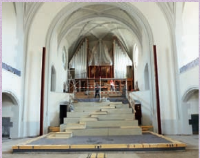
Einbau der neuen Stufenanlage
