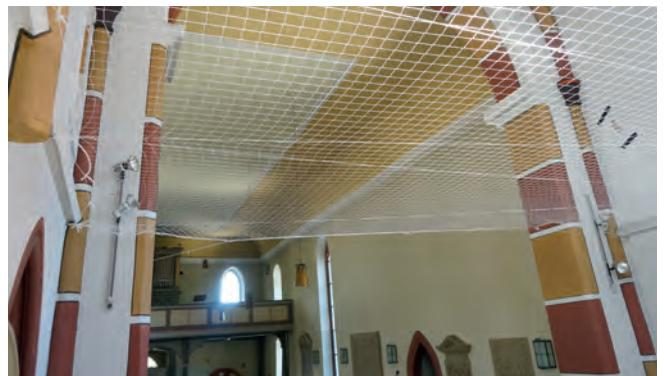
Fast so alt wie Heiligkreuz: die Michaelskirche in Hilsbach. Massive Schäden an Dach und Mauerwerk machen eine umfassende Sanierung nötig, ein Netz schützt vor herunterfallenden Teilen.
