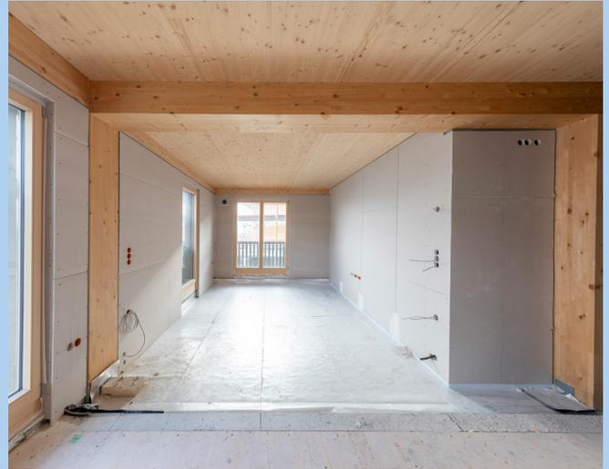
in die Außenwände integriert sind. Das Gebäude ist in Gebäudeklasse 4 eingestuft. Beim Aufbau der Holzaußenwände werden ohne Abweichung die brandschutztechnischen Regeln der Muster-Richtlinie DIN 4102-4 eingehalten.
