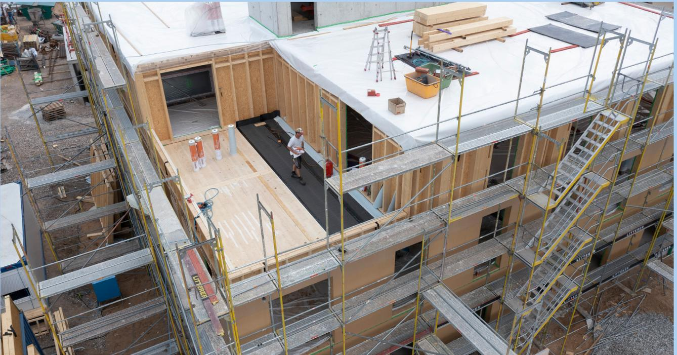
vorgefertigten Bauteilen (Brettspertholz-Decken, Unterzüge und Stützen aus Brettschichtholz) und lokalen Zimmermannsarbeiten (Holzrahmenbauelementen mit hohem Vorfertigungsgrad, Fassadenbekleidung aus vorbewitterter Holzverschalung) konnte flexibel auf den Markt reagiert werden.
