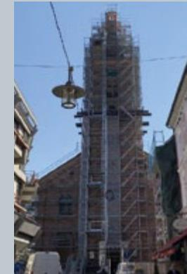
sade gereinigt und schadhafte Stellen erneuert. Zusätzlich wurden neue Schallläden eingebaut. Dazu musste der gesamte Turm eingerüstet werden, ein wesentlicher Kostenpunkt. Ergänzt wurde diese Maßnahme durch eine neue Lautsprecheranlage und kleinere Instandsetzungen im Kircheninnenraum.
